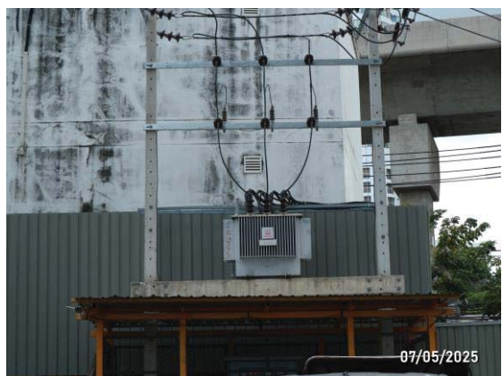
รูปที่ 3-49 หม้อแปลงไฟฟ้า
