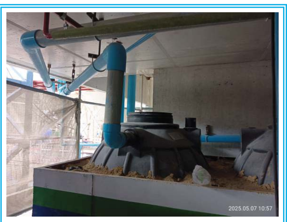
รูปที่ 3-40 ระบบบำบัดน้ำเสียสำเร็จรูป
