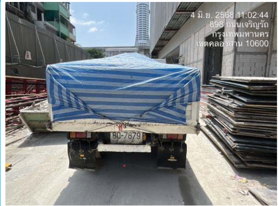
รูปที่ 3-19 รถบรรทุกขนส่งดิน และรถบรรทุกขนส่งวัสดุ ปิดคลุมด้วยผ้าใบทึบ
