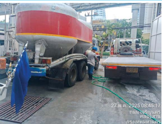
รูปที่ 3-20 คนงานทำความสะอาดล้อรถบรรทุก
