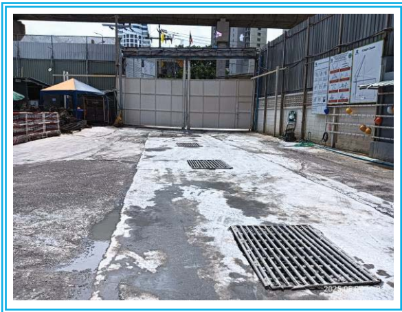
รูปที่ 3-32 เครื่อง Water Jet และพื้นที่สำหรับล้างล้อรถบรรทุกก่อนออกจากพื้นที่โครงการ
