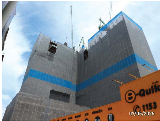
รูปที่ 3-22 ผ้าใบ Mesh Sheet คลุมอาคาร
